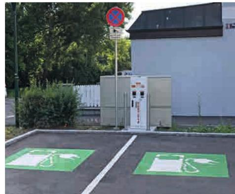
Die neue E-Ladestation am Lindenweg 1: Zwei Ladepunkte, mit je 11 kW stehen zur Verfügung.
