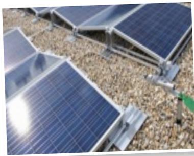
**Im September 2013** erfolgte am Dach des Küchengebäudes die Inbetriebnahme der dritten Photovoltaikanlage. Auch diese Anlage ist ein Überschusseinspeiser. Die erwirtschaftete Jahresproduktion 01.01.2022 bis 31.12.2022 beträgt 3.709 kWh.
