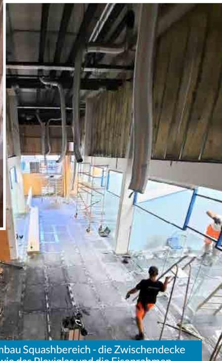
Umbau Squashbereich - die Zwischendecke sowie das Plexiglas und die Eisenrahmen wurden demontiert. Der Bereich bekommt ein neues Luft- und Heizungssystem
