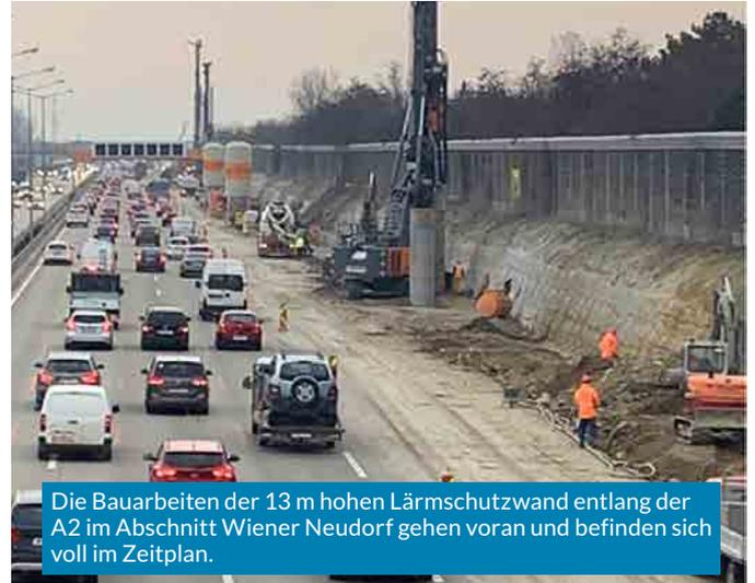
Die Bauarbeiten der 13 m hohen Lärmschutzwand entlang der A2 im Abschnitt Wiener Neudorf gehen voran und befinden sich voll im Zeitplan.
