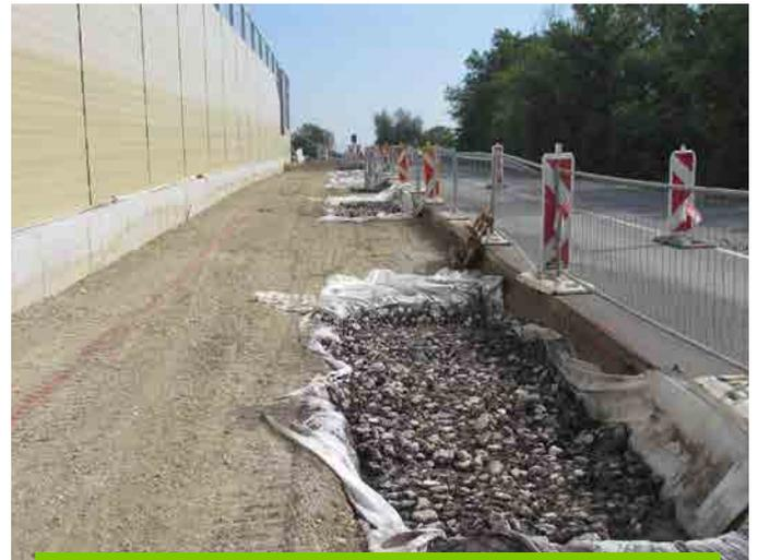
Umsetzung „Prinzip Schwammstadt“ in Wiener Neudorf. Entlang der Geh- und Radwege wurden große Gruben (ca. 1,8 x 4,0 m) für die zu pflanzenden Bäume ausgehoben, mit Geo-Vlies ausgekleidet und mit grobem Material und Humus befüllt. Die Gruben befinden sich teilweise unter dem Geh- und Radweg sowie unter dem Pflanzstreifen zwischen Fahrbahn und Radweg.
