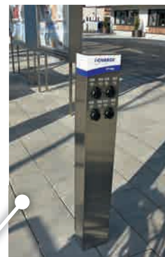
i-Charge ist eine öffentliche Ladestation und wird gespeist durch die gewonnene Sonnenenergie, z.B. zum Aufladen des Akkus für Ihr E-Bike.
