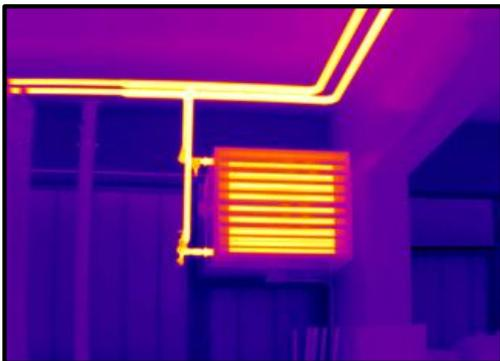
ständige Durchströmung auch wenn der Heizlüfter nicht in Betrieb ist --> Energiebedarf
