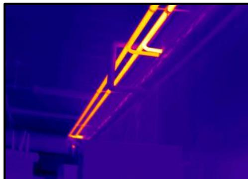
Wärmeverlust durch ungedämmte Rohre in den Hallen
